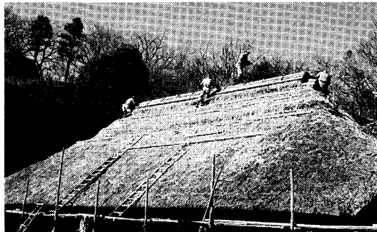
重要文化財旧北村家 茅葺屋根修理
