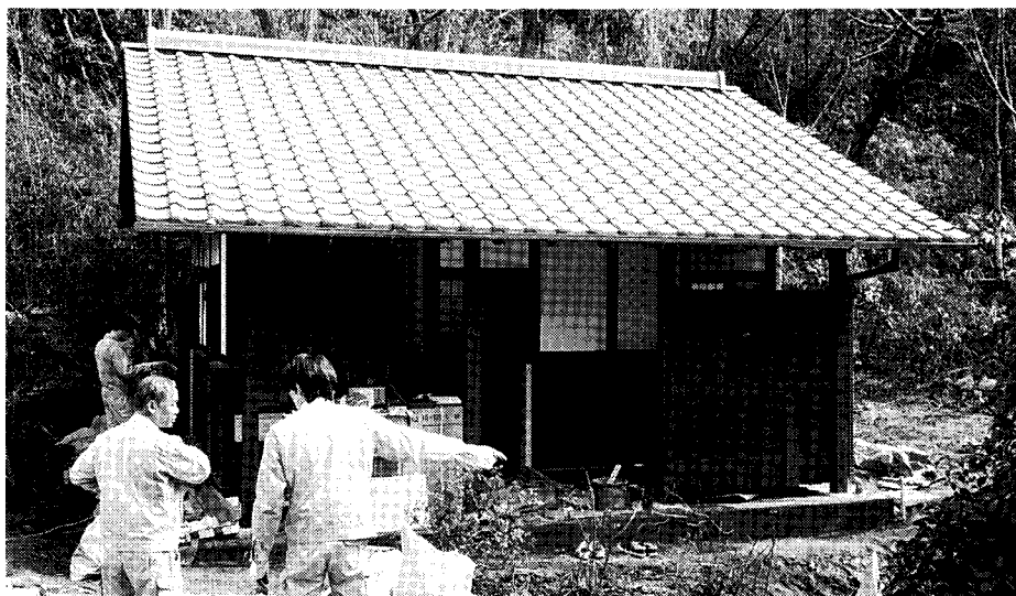
日本民家園出口 警備員立哨所付水洗便所竣工間近
