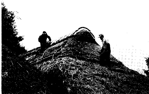
重要文化財旧作田家 屋根棟修理
